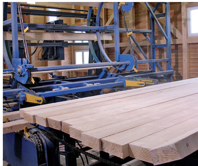
Sortieranlage lieferte WDT – um Qualitätssortierung durchführen zu können, werden zwei Etagen über Bogenförderer beschickt
